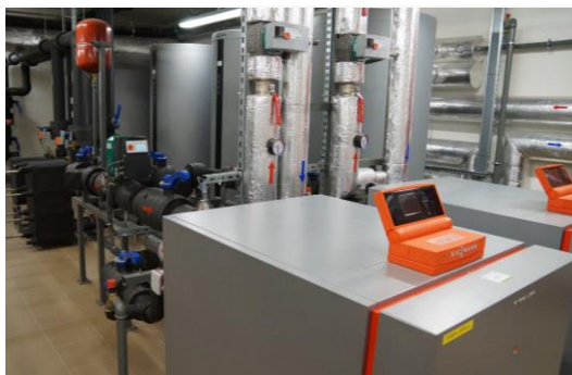
Stanowisko regulacji i automatyki pomp ciepła.
