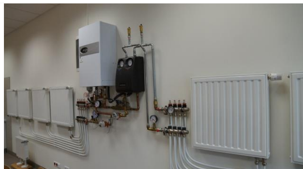
Instalacja modelowa systemu grzewczego zasilanego kotłem elektrycznym o mocy 6 kW.
