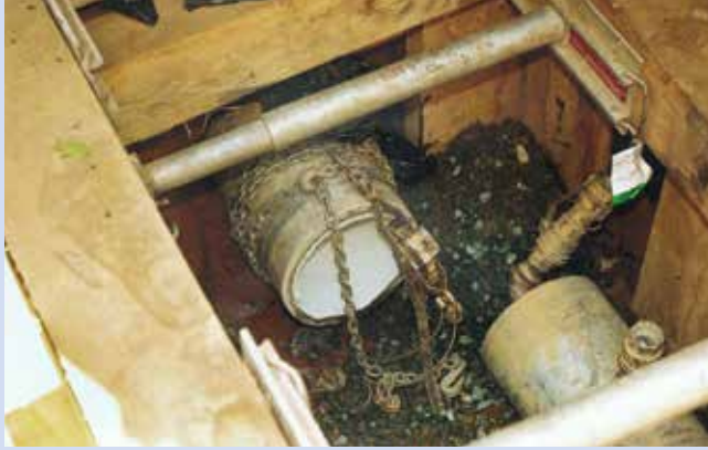
Ryc. 8. Rura azbestocementowa po naprawie, fot. za: „Trenchless International” 2015, nr 27
