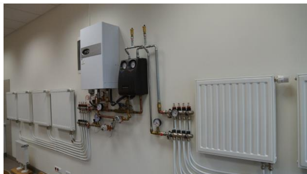
Instalacja modelowa systemu grzewczego zasilanego kotłem elektrycznym o mocy 6 kW.
