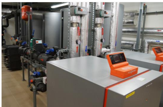
Stanowisko regulacji i automatyki pomp ciepła.
